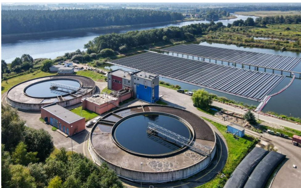
Foto: saules enerģijas elektrostacija Slokas notekūdeņu attīrīšanas stacijā.
