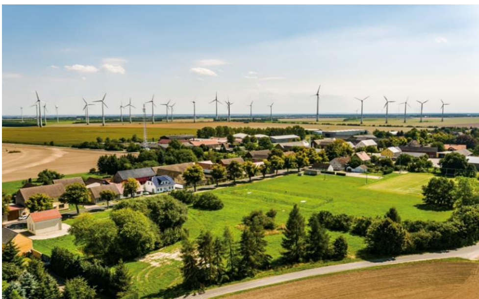
Foto: enerģētiski pašpietiekams Feldhaimas ( Feldheim ) ciemats ar vietējo vēja un saules infrastruktūru. Avots: Energiequelle ( https://www.energiequelle.de/en/projects/lighthouse-projects )
